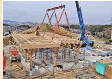
日本建築構造技術者協会(JACA) 新人賞や日本構造デザイン賞、日本土木学会デザイン賞 2016 最優秀賞、第8回キッズデザイン賞・キッズデザイン会長賞等を受賞した岡村仁先生にお願いしました。通常使われる木造の1.5倍ほど大きな柱(180×180)を数多く配置していることが特徴で、柱と頓杖(斜め材)、屋根梁(格子梁)が一体となって、樹木のような強いフレームを形成しています(剛接架構)。住宅など普通の木造建物は筋交い(壁)によって地震に抵抗しますが、剛接架構はこれに比べて粘り強い構造となっており、当園では柱の下部に特殊な接合方法を用いるなど、さまざまな工夫がなされています。また、大地震に対しては、耐震設計の標準的な数値である設計せん断力係数(CO)を通常(0.2)の1.5倍(=0.30)で設計しており、高い耐震性を確保すると同時に、台風などの強い風に対しても強い構造となっています。
